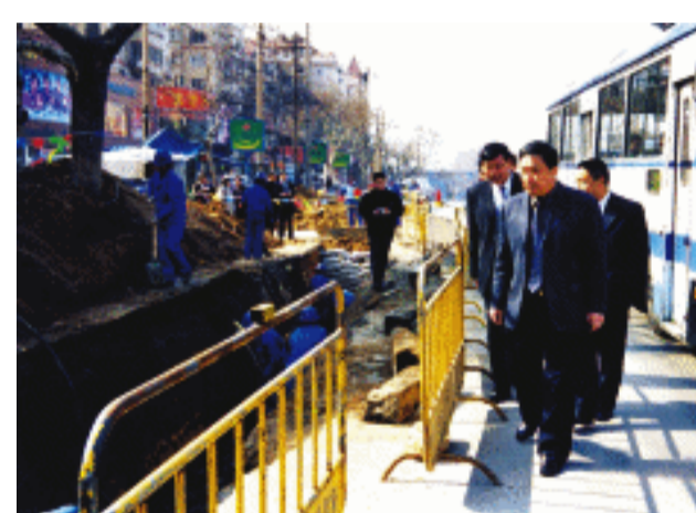
《青岛市市政公用基础设施特许经营暂行规定》和《青岛市供热条例》的有关规定,对安全生产、供热质量和质量等不达标,整改后仍不符合规定的,取消供热经营资格,对违反《供热特许经营协议》的供热特许经营企业,要按照协议规定进行处罚。出现危及公共安全、影响公共服务的情况,要按照协议规定取消其特许经营权并实施临时托管,以保证城市居民连续稳定供热。
